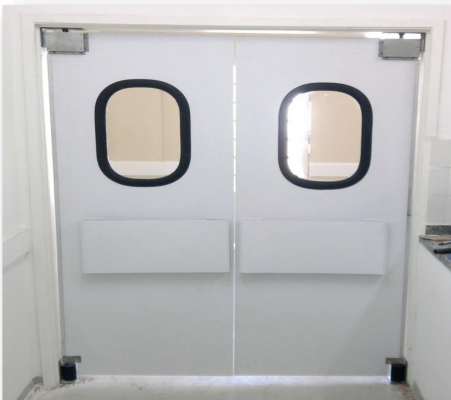
Figura 27 - Porta de Acesso a Sala de Recuperação Pós-anestésica
